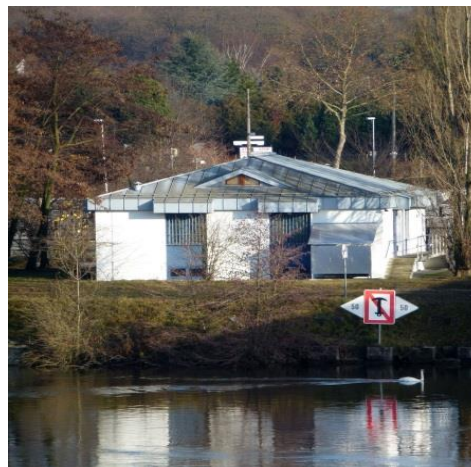
Rheinüberwachungsstation Weil (RüS) 60
