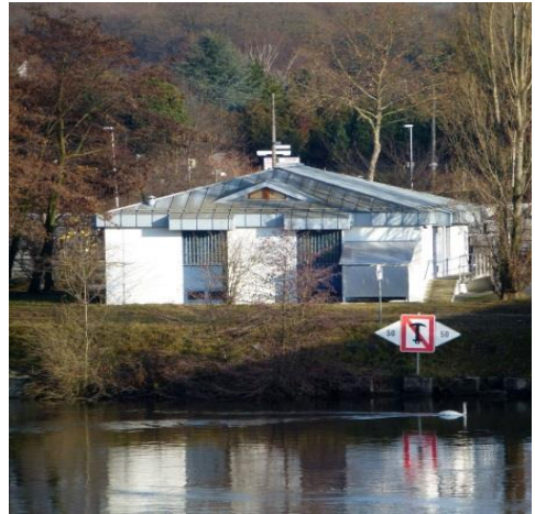
Rheinüberwachungsstation Weil (RüS)
