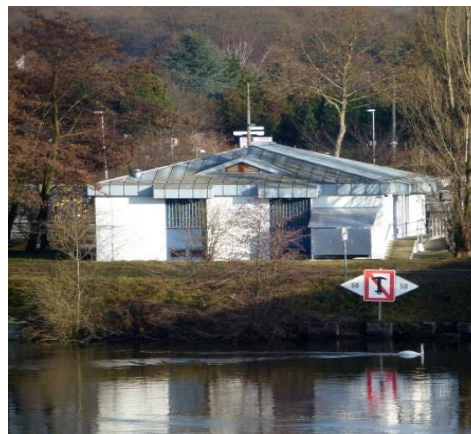
Rheinüberwachungsstation Weil (RüS) 53
