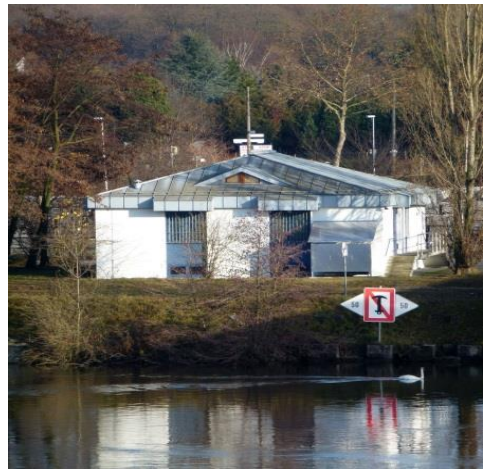
Rheinüberwachungsstation Weil (RüS)
