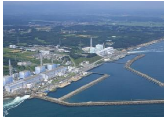
Kernkraftwerksgelände von Fukushima Dai-jchi
