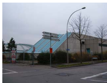
Zwischenpumpwerk der ARA Basel
